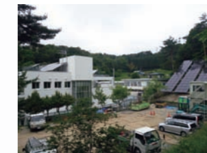
東側外観と太陽光パネル (法面) East Elevation and Photovoltaic panel (Hill slope)
