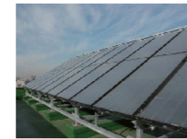
太陽熱パネル Solar thermal panel
