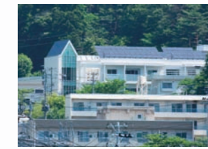
国道 4 号線からの遠景 View from Route 4
