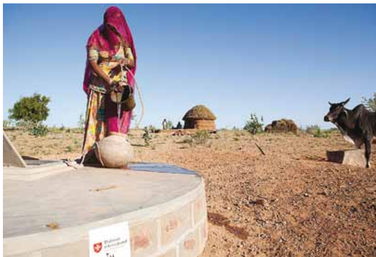
Des réservoirs de stockage d'eau de pluie enterrés au Rajasthan, en Inde CARMEN WOLF
