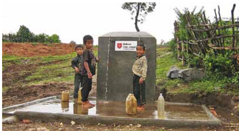
Systèmes d'adduction d'eau par gravité à Lai Rai dans la région de Wa au Myanmar
