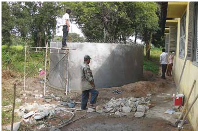
Construction d'un réservoir en ferrociment dans une école (Malteser International, Cambodge)
