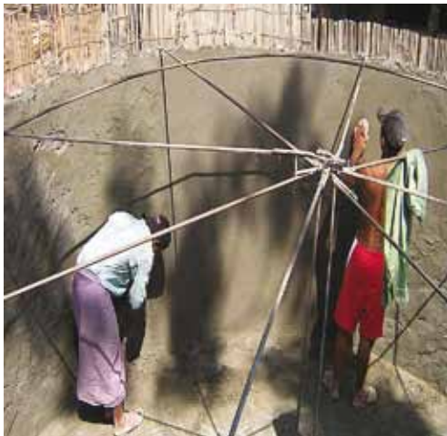
Construction d'un réservoir en ferrociment dans une école au Myanmar
