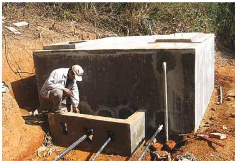
Boîte de captage d'une source à Mongla dans la région spéciale de Shan au Myanmar
