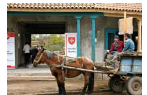
Chile: neues Marktgebäude mit Platz für Büros und Werkstätten von 20 Kleinunternehmen
