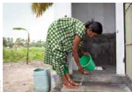
Sri Lanka: Bau von 200 Haushaltslatrinen im Distrikt Batticaloa
