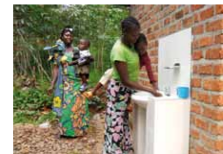
DR Kongo: Sanitäre Anlagen für 36 Gesundheitszentren und sechs Krankenhäuser in sieben Gesundheitszonen
