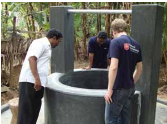
Mitarbeiter von Malteser International begutachten einen der 170 sanierten Brunnen im Norden des Landes.
