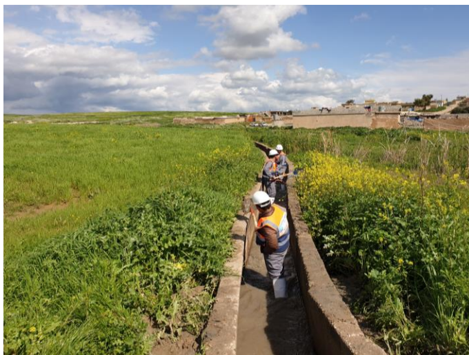
Photo 1: Projet de réhabilitation des canaux d'irrigation.
